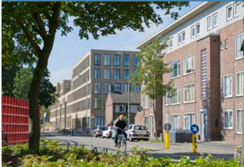
Nieuwe en nog te slopen bebouwing in Boschveld.
